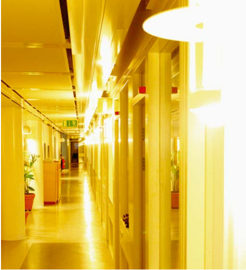
Figur 53. I denna korridor finns lampetter som är avsedda för traditionella glödlampor. Man har dock ersatt glödlamporna med lågenergilampor som är några centimeter längre. Följden blir att de bländskydd som skärmade av glödlampans direkta sken mot den som passerar i korridoren nu sitter fel, lågenergilampornas lysande del sticker ut nedanför bländskyddet (se även Figur 32) och ger en kraftig bländning. Att bygga om armaturerna är inte tillåtet om det innebär att CE-märkningen inte längre gäller.
