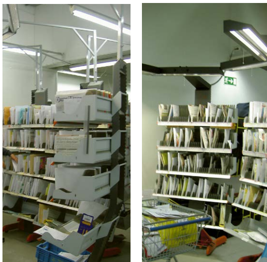
Figur 66. Postsorteringshyllor före (A) och efter (B) montering av asymmetrisk belysning.
