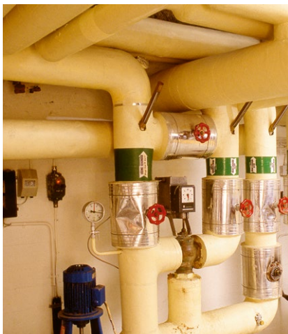
Isolerade rörböjar.
