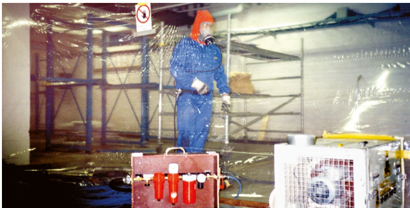
Ventilator och reningsenhet för andningsluft placerat utanför det avskärmade området. Inne i området bakom plasten finns saneraren. Obs! Felaktigt handskmaterial.
