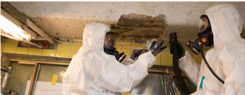
Asbestsanering av ventilationskanal.
