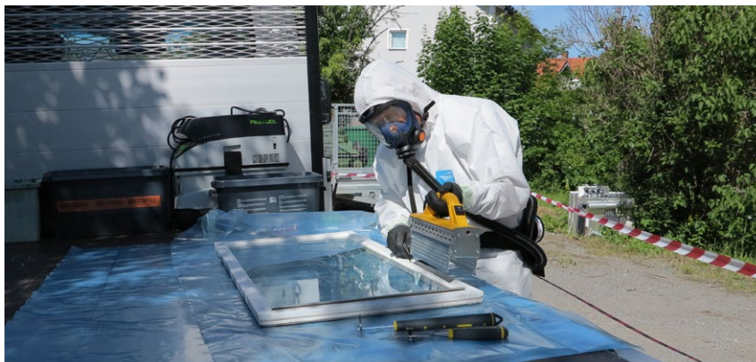
Sanering av fönsterkitt.
