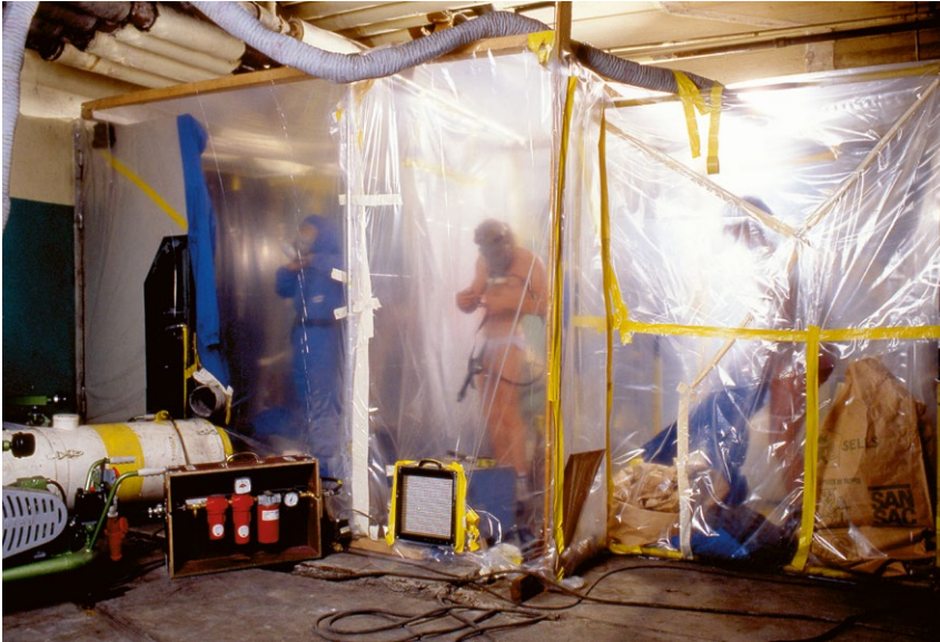
En platstillverkad 3-stegssluss.
