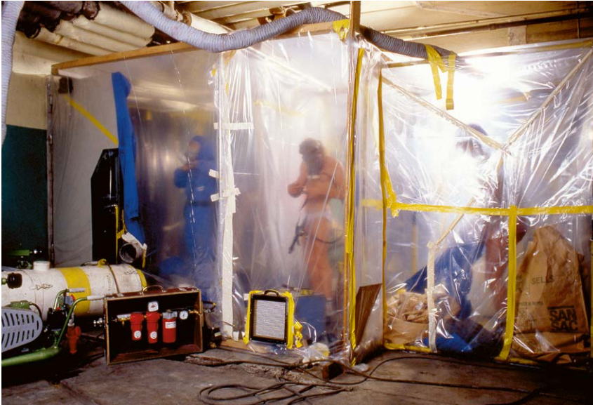
En platstillverkad 3-stegssluss.
