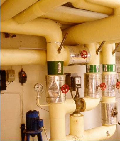
Isolerade rörböjar.
