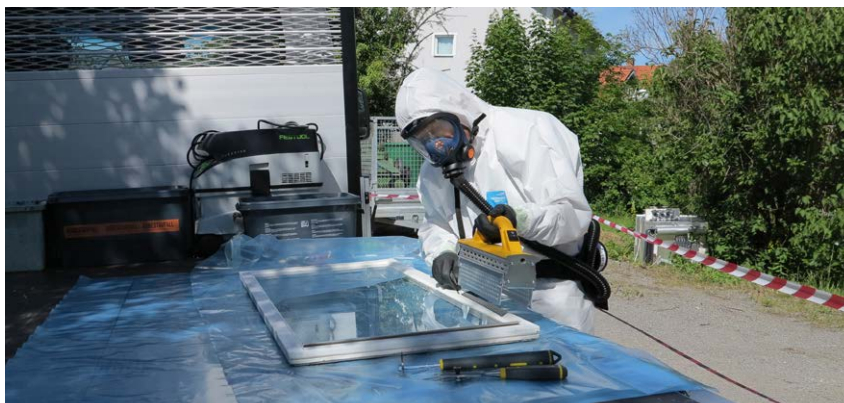
Sanering av fönsterkitt.
