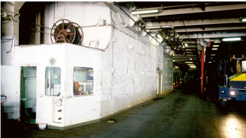
Lastramp på fraktfartyg. Sprutasbest med täckskikt på brandavskiljande skott mellan däck och förbindelsevägar.
