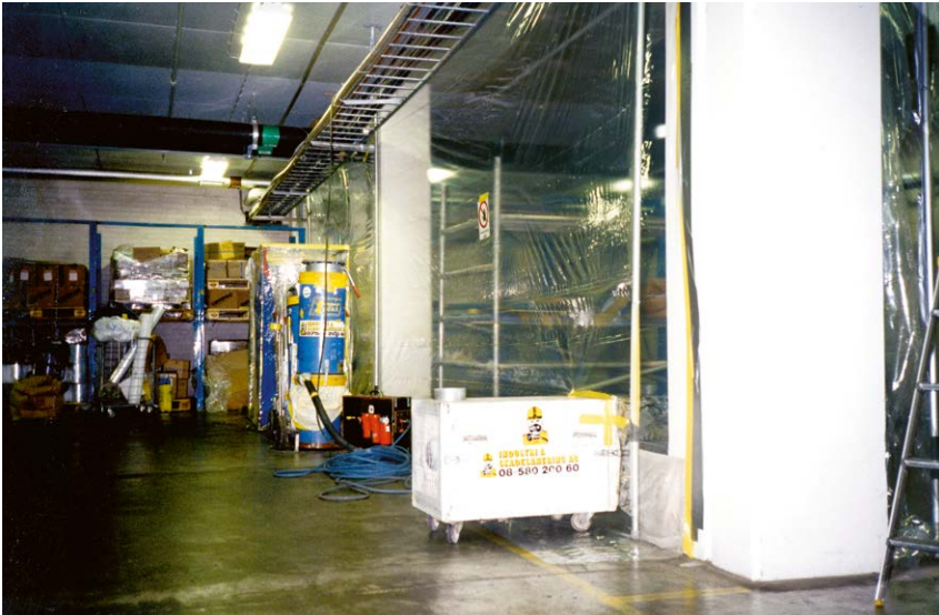
Sanering pågår. Den ljusa enheten i förgrunden är en "dammfälla" som skapar undertryck i saneringsutrymmet och styr ventilationen. Ett mikrofilter renar frånluften från damm till 99,95 procent. Luftomsättningen är 4 000 m 3 /timme.
