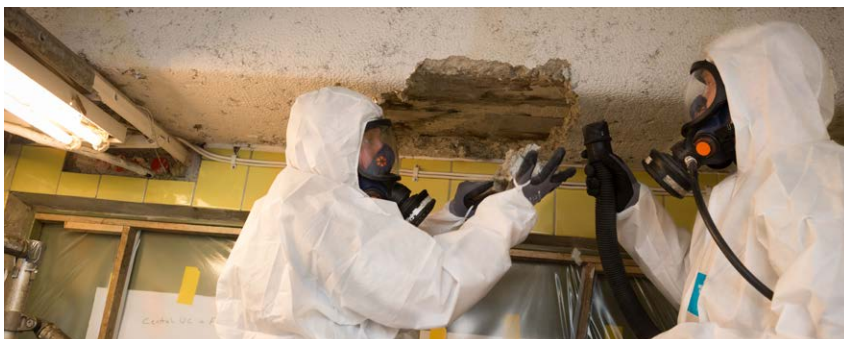
Asbestsanering av ventilationskanal.
