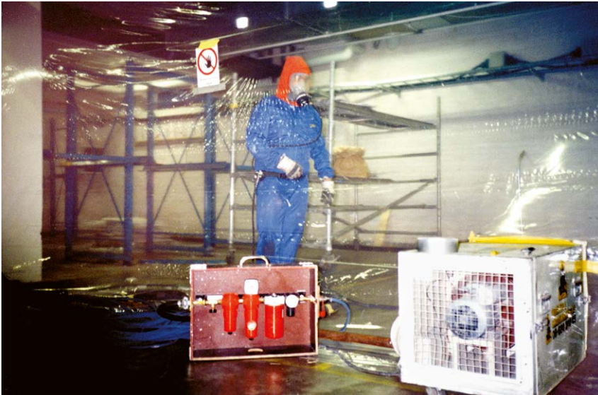
Ventilator och reningsenhet för andningsluft placerat utanför det avskärade området. Inne i området bakom plasten finns saneraren. Obs! Felaktigt handskmaterial.
