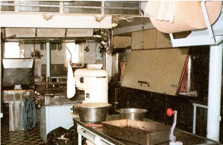
Fixmassan i det här köket innehåller asbest.
