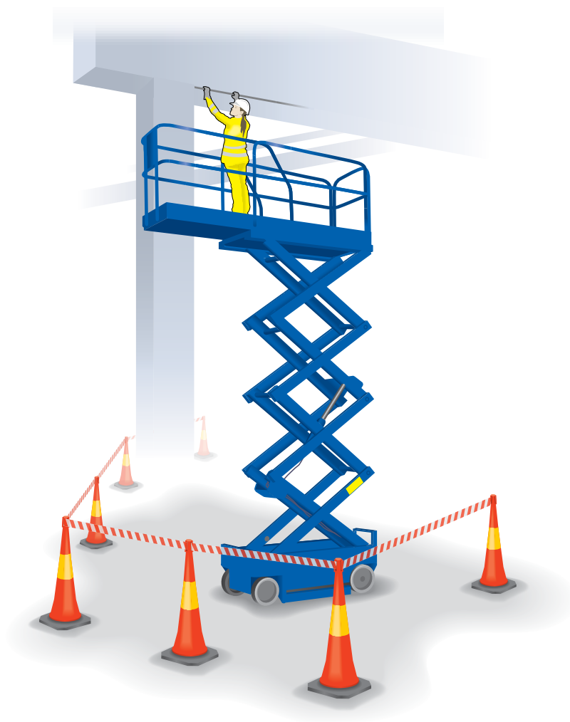
Figur 9. Illustration av arbets- och riskområde. En avspärrning signalerar till omgivningen att vara uppmärksam samtidigt som det skapar trygghet för elektrikern.
