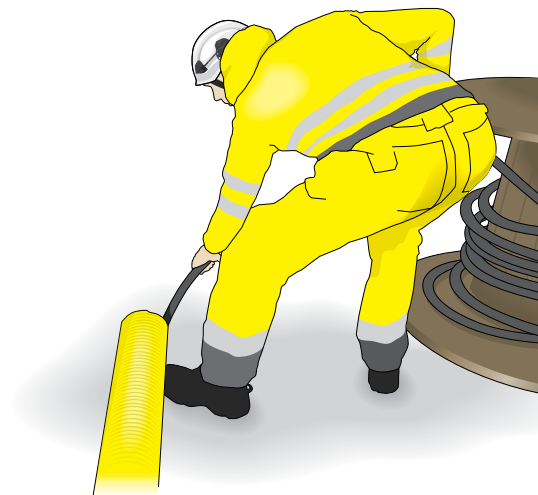
Figur 16. Arbetet med en böjd och vriden arbetsställning belastar ländryggen. Här vid inmatning av kabel i markrör krävs dessutom muskelkraft för att hålla kroppen i balans. Ta en paus då och då och sträck på ryggen. Och använd tekniska hjälpmedel när det är möjligt.
