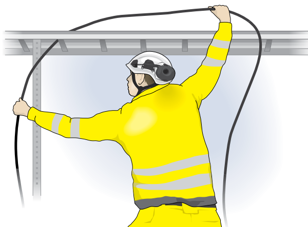
Figur 15. Arbete med uppåtförda armar medför en statisk belastning och är påfrestande för nacke, axlar och rygg. Här, med matning av kabel, sker arbetet med upprepade arbetsrörelser och delvis i ledernas ytterlägen vilket ökar belastningen. Försök komma så nära arbetsobjektet som möjligt så att det går att jobba med överarmarna intill och framför kroppen. Ta korta pauser då och då, släpp ner armarna, titta rakt fram och rör på kroppen. Tänk på att en lättare hjälm med kort skärm som inte begränsar synfältet innebär en minskad belastning för nacken.
