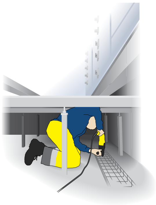
Figur 12. Arbete ovan och under installationsgolv. Projektören och BAS-P ansvarar för att det går att utföra ett arbete i en god arbetsmiljö och inte som bilden illustrerar. Arbetsutrymmet ska vara tillräckligt stort för att elektriker ska kunna röra sig, hantera arbetsmaterial och nödvändiga verktyg samt ha plats för utrustning som underlättar arbetet. Det kan till exempel gälla ett ställverksgolv som ska vara lätt att arbeta med, demontera, underhålla samt renovera efter år av användning.
