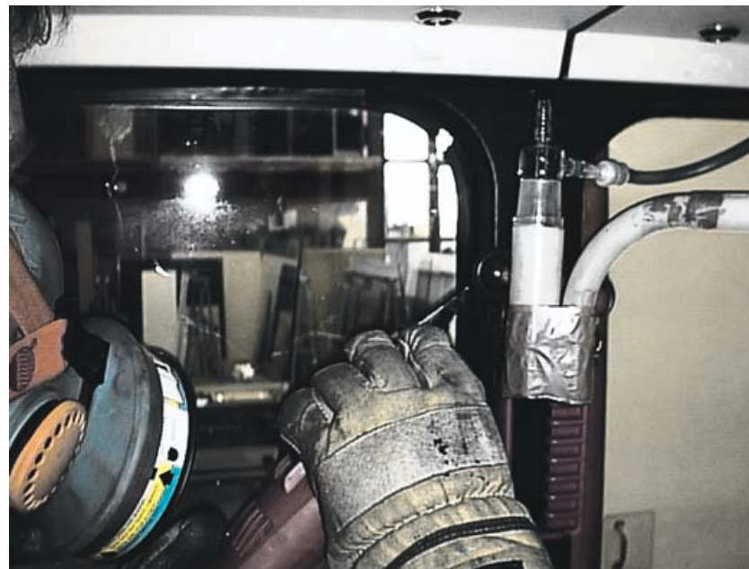
Demontering av bussruta med Fain-kniv. Halten isocyanater mättes i samband med demonteringen. Till höger syns utrustningen för provtagning av isocyanater.
