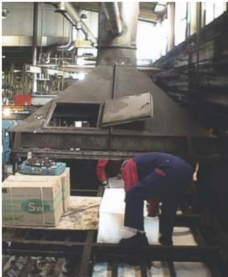
Isolering av en ugn på ett stålverk. De eldfasta fibrerna är av AES-typ (eldfast mineralull).
