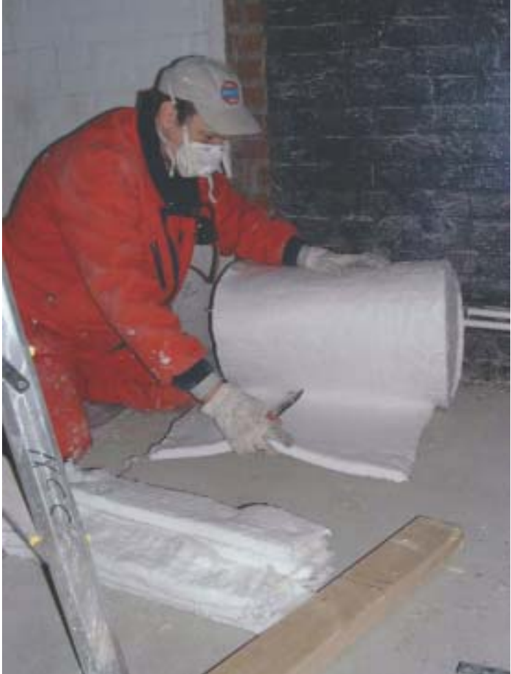
Tillskärning av eldfasta fibrer (eldfast mineralull, AES). Andningsskyddet är ett partikelfilter klass P2. Hanteras fibrer som misstänks orsaka cancer, rekommenderas ett bättre andningsskydd.
