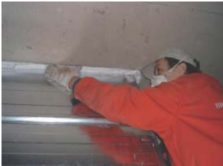
Montering av eldfasta fibrer (eldfast mineralull, AES). Andningsskydd.
