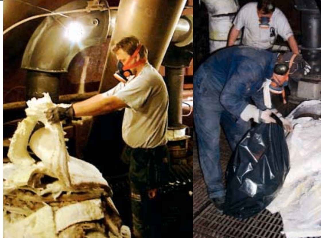
Rivning av isolering på ett fjärrvärmeverk.
