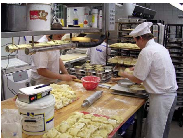
Figur 5. Exempel på fast monterat punktutsug över bakbordet. Avståndet mellan dammkälla och utsug är för stort. Kapaciteten i utsuget är också för liten. Utsuget har begränsad betydelse för personalens exponering.
