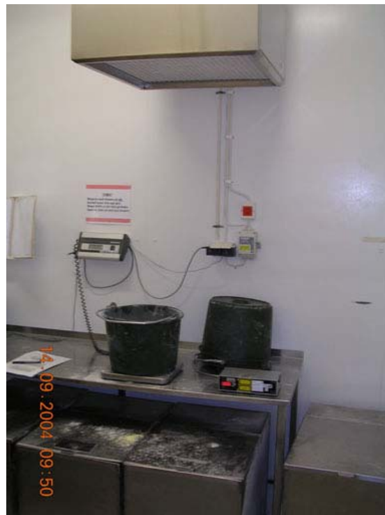
Figur 3, ovan till höger. Tilluftsdon för deplacerande ventilation. Bilden från en bilverkstad. För att minska draget har en bilplåtslagare placerat en dörr för en del av donet. Partiella hinder har dock ingen större betydelse för lufttillförseln. Arbetsplatser bör inte vara placerade för nära deplacerande tilluftsdon.
